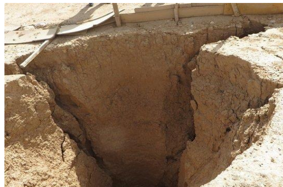
شکل ۱: فرونشست در محدوده راه آهن شیراز- اصفهان [۲] Fig. 1: Subsidence in the area of Shiraz-Isfahan railway [2]
