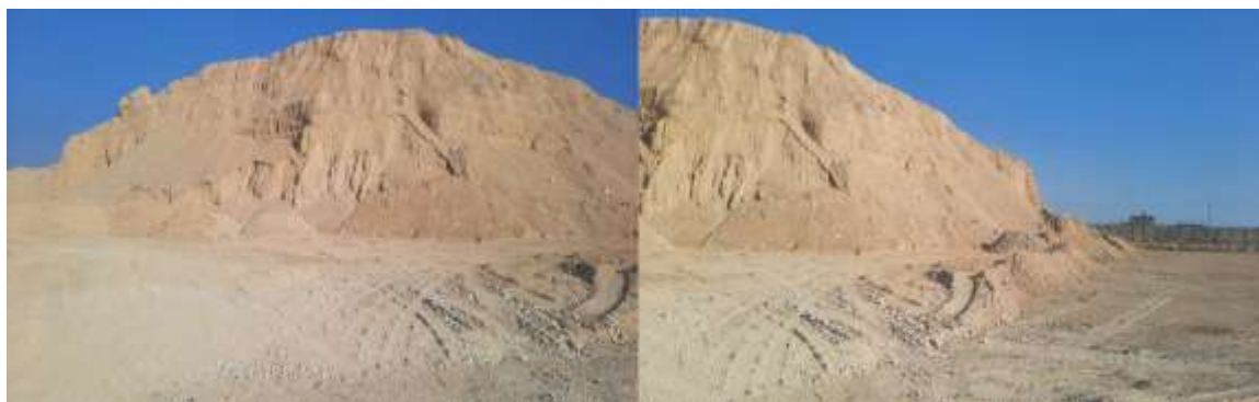
شکل ۱: ترانشه موضوع مطالعه
