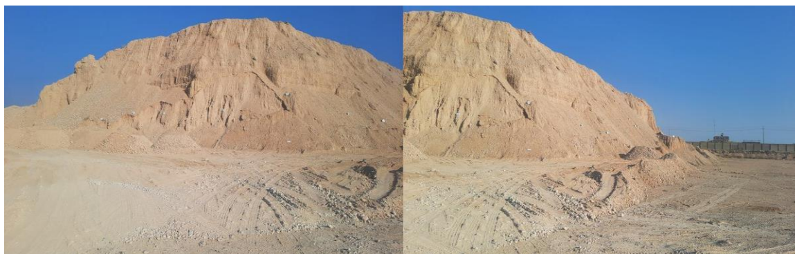
شکل ۱: ترانشه موضوع مطالعه
